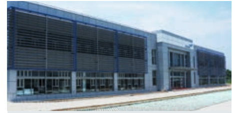
Plansee HLW baut ein neues Werk in Shanghai, China.
